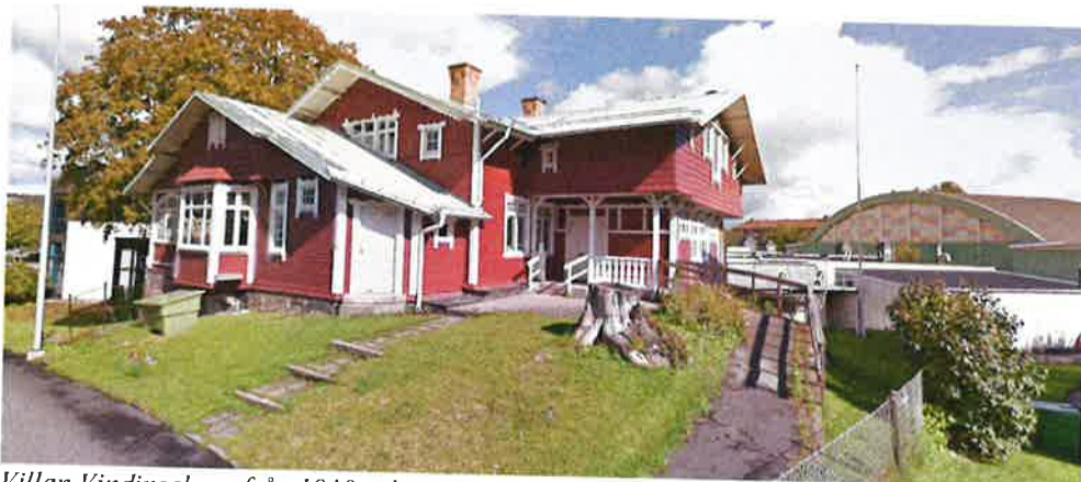
Villan Vindingsborg från 1910-talet uppförd i nationalromantisk stil med välbevarade detaljer såsom takkonsoler, fjällpanel, figursågade fasaddetaljer, fönster med småglas och träspröjsar.
