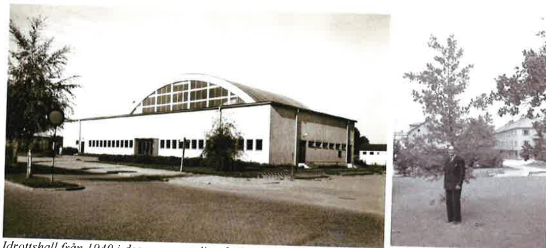
Idrottshall från 1940 i dess ursprungliga funktionalistiska stil och Knut Fridell framför OS-eken 1947.
