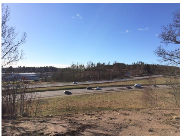
Hogstorsvägen och Rv44 sett från bergknallen.
