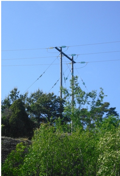
I planområdets norra del återfinns en högspänningsledning.
