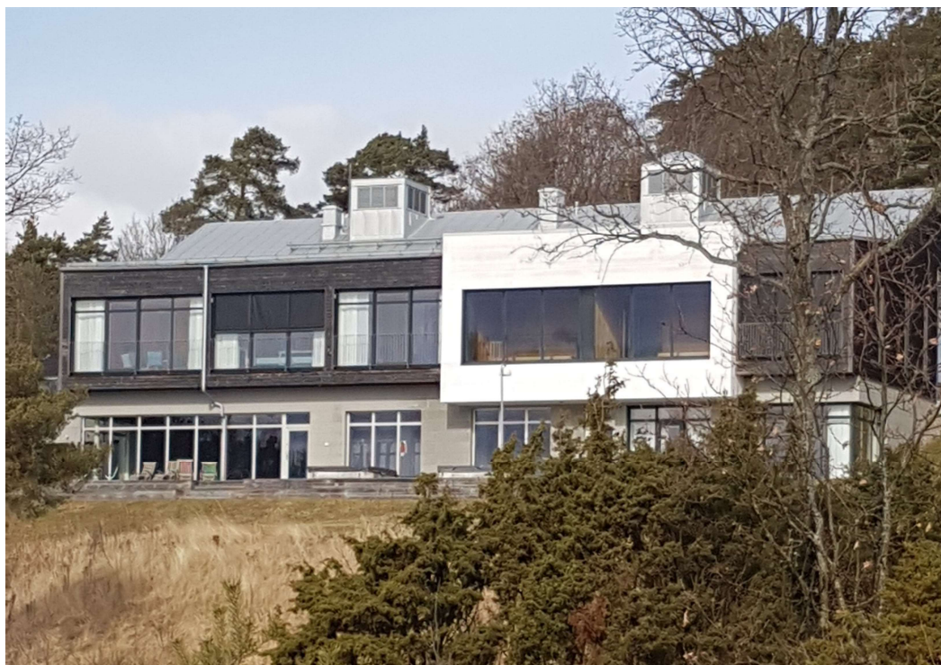
Del av centralanläggning på Bjällansås 1:4.
