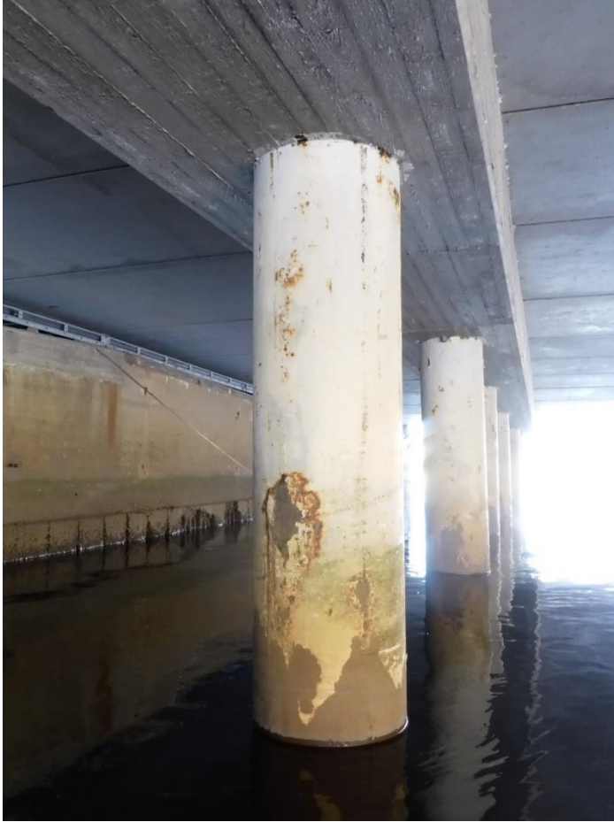
Figur 3. Bild på stål-betongpålar från AFRYs inspektion 2023.
