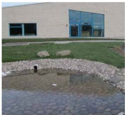
Referensbilder dagvatten fördröjningsdamm. Appelgården, Liljewall arkitekter
