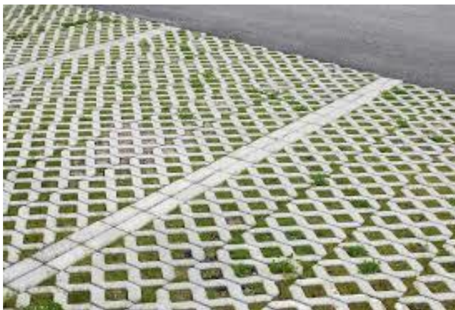
Figur 19. Exempel på P-yta med gles plattsättning som genomsläppligt material.
