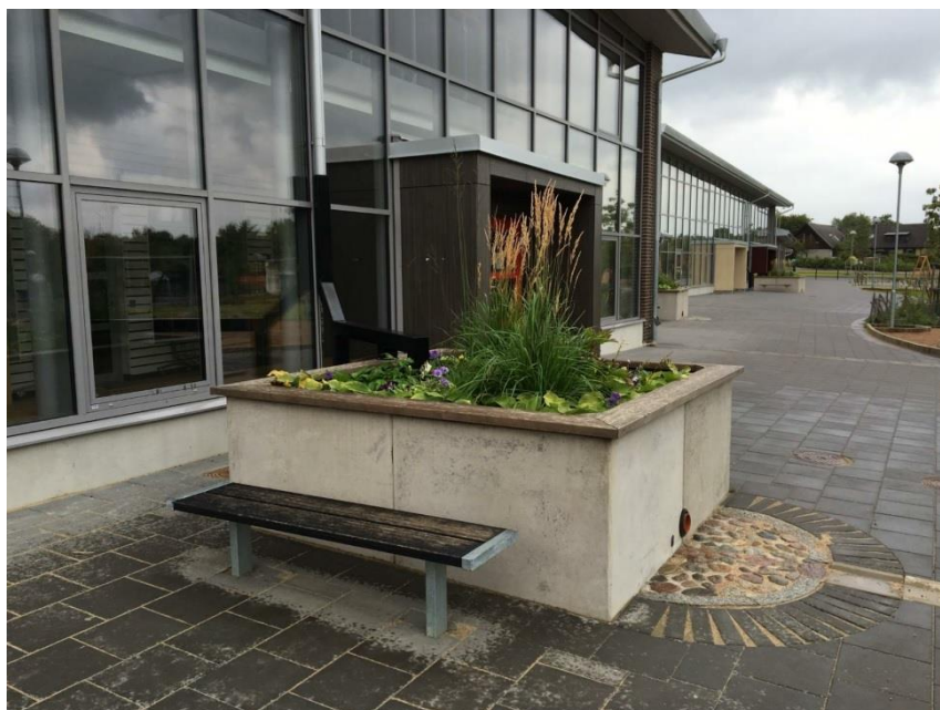
Figur 22. Växtbädd för rening och fördröjning av takvatten. Figuren visar en lösning där vatten kan fortsätta filtrera ner i underliggande mark, men avtappning kan även ske via ett anlagt utlopp. (Bildkälla: Kent Fridell)
