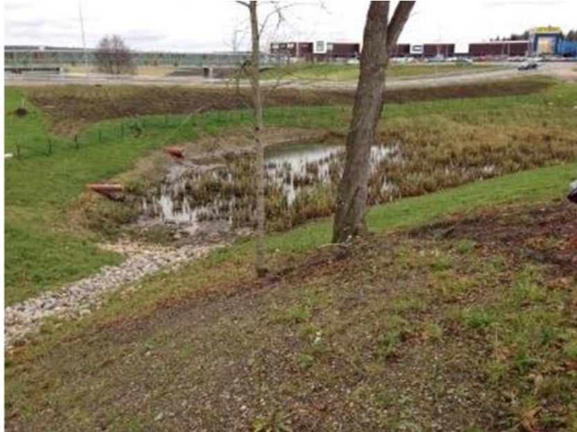
Figur 9 Bild tagen vid fältbesök 2013-11-16. Dagvattendamm öster om väg E6.
