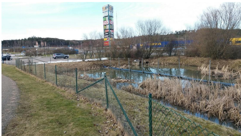
Figur 6 Befintlig dagvattendamm inom planområdet sedd åt nordost. I mitten av dammen syns en blå oljeläns.
