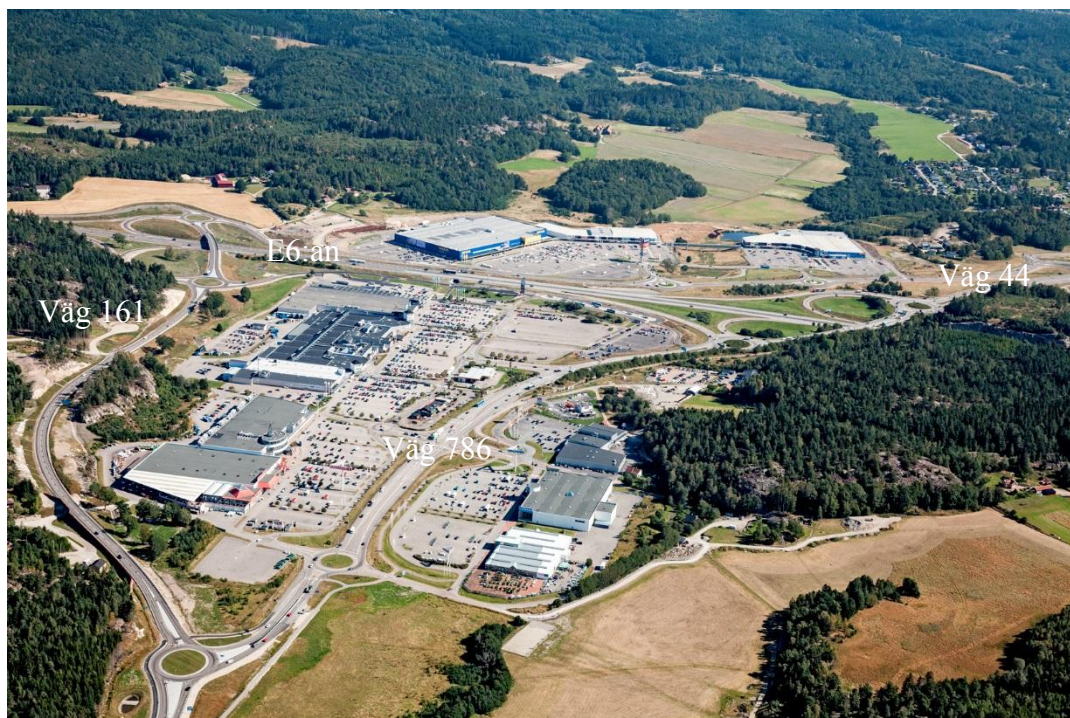
Figur 1. Översikt befintligt Torp Köpcentrum.
