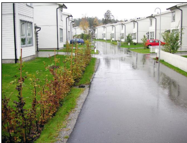
Figur 11. Makadamdike mellan lokalgata och tomtmark. Källa: Stockholm vatten och avfall.
