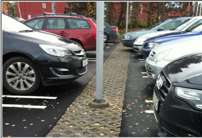
Figur 13. Ett raster av betong förhindrar mindre partiklar från att komma in i makadamlagret i diket. Bildkälla: Stockholm vatten och avfall.
