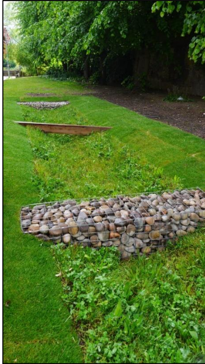
Figur 15. Trappat dike, bildkälla: Jonathan Malmberg ( Ekosystemtjänster för klimatanpassning – dagvattnelösningar och temperaturreglering - PBL kunskapsbanken - Boverket )
