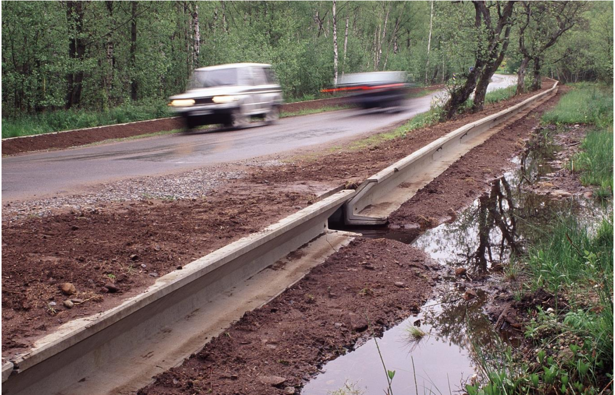
Fig 8. Grodtunnel med ledarmar.
