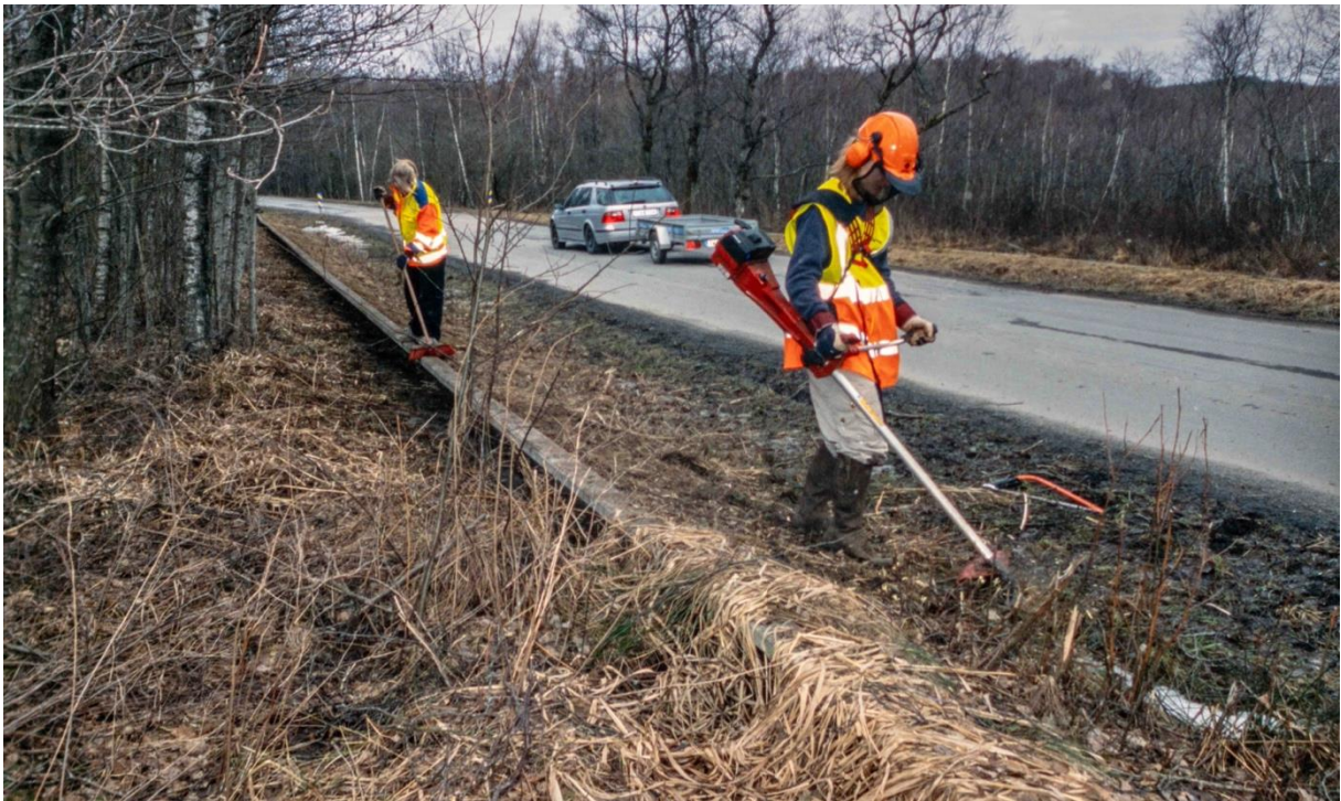
Fig 9. Rökning av ledarmar till grodtunnel. Åtgärd som utförs för att hindra groddjur att klättra över skärmen med hjälp av uppvuxen vegetation.
