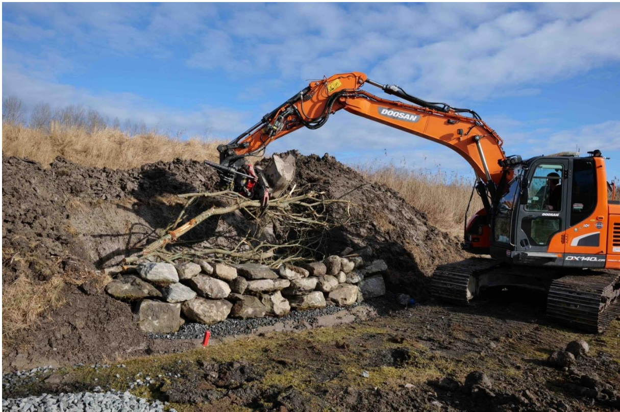
Fig 10. Uppbyggnad av övervintringsplats för grod- och kräddjur. Innanför stenmuren ligger grenar och som bryts ned och skapar värme. Konstruktionen täcks med jord.
