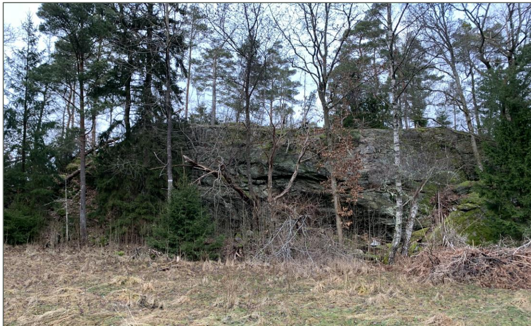
Figur 7. I det sydvästra delområdets sydöstra hörn blottas en ca 8 m hög vertikal slänt.
