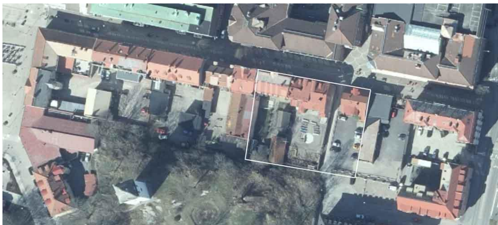
Bilden ovan visar ett Ortofoto över kvarteret Krummedike. Utredningsområdet markerat med vit linje. Källa: www.fornsok.se 2022-02-09.
