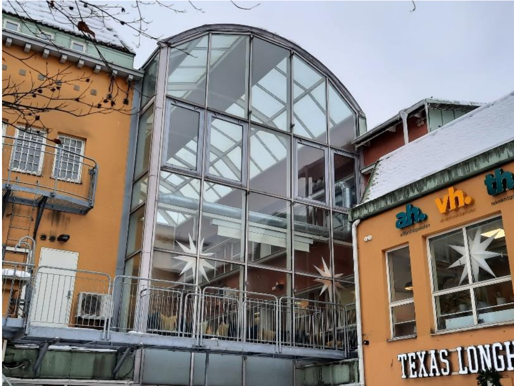
Inglasning vid Kochska gränden. Exempel på hur inglasning kan bli. Kraftigare dimensioner, speglingseffekt som gör att man inte ser husfasaden innanför tydligt, samt också eventuellt behov av ventilationsanläggning.
