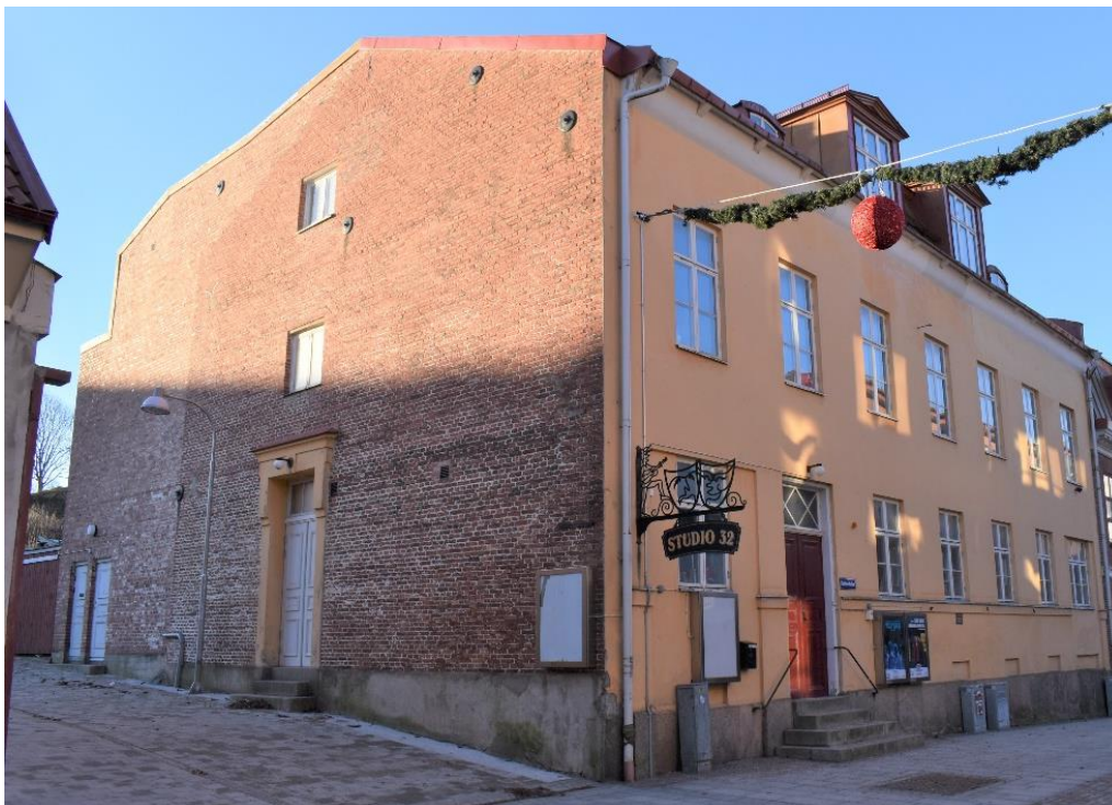
På gaveln finns ytterligare en entré med portal och granitrappa samt trappfönster på de två våningsplanen. I gavelns södra hörn finns två senare tillkomna parställda dörrar. På fasaden finns dessutom ett antal ankarjärn i olika former samt en murad valvbåge som troligen är spår av ett tidigare fönster. Genom tydliga färgskillnader i det äldre teglet jämfört med det senare tillkomna, framträder tydligt den ursprungliga husformen.
