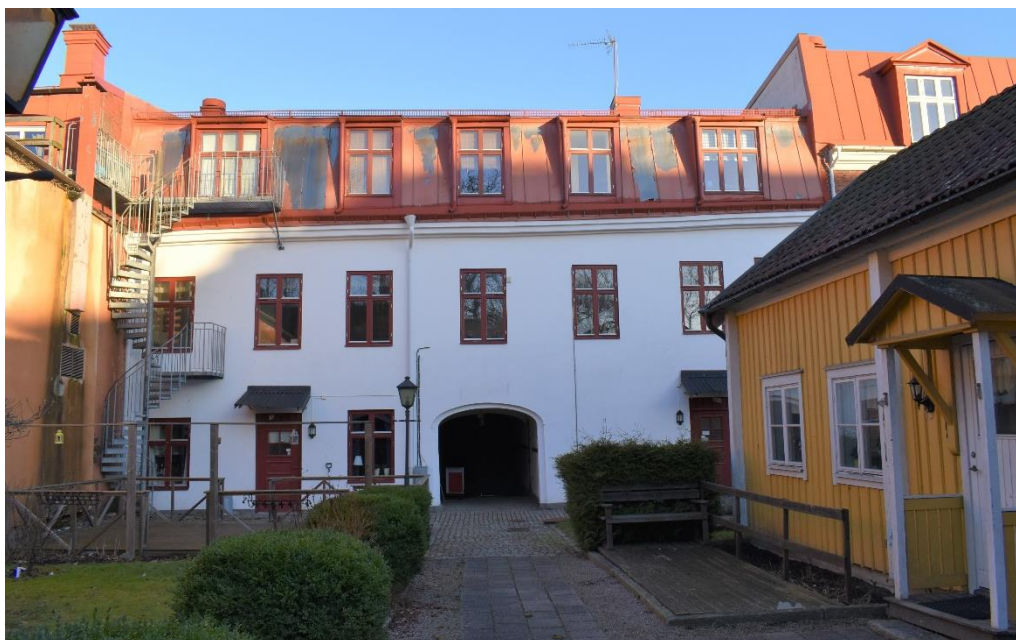
Gårdsfasaden är vitputsad och har ett enkelt arkitektoniskt uttryck. På det brutna taket, som är klätt med röd falsad plåt, finns fem takkupor. Fönstren mot gården utgörs av korspostfönster utan spröjs. Fönstren ersatte de äldre fönstren under perioden 2013–2015 och tillverkades med de äldre fönstren som förlagor. En brandtrappa är placerad i anslutning till husets västra hörn och har åtkomst både från andra och tredje våningen.
