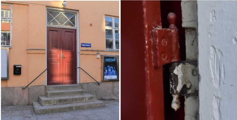
Entrén med dubbeldörrar är placerad i byggnadens östra del. Över dörrarna sitter ett krysspröjsat överljusfönster. I anslutning till entrén finns en granitrappa och på var sida om entrén återfinns två smidesledstänger. Gångjärnets utformning var vanligt förekommande under 1800-talets första hälft.
