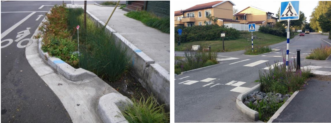
Nedsänkta växtbäddar som bidrar till rening och fördröjning av dagvatten, så kallade "rain gardens" eller biofilter.
