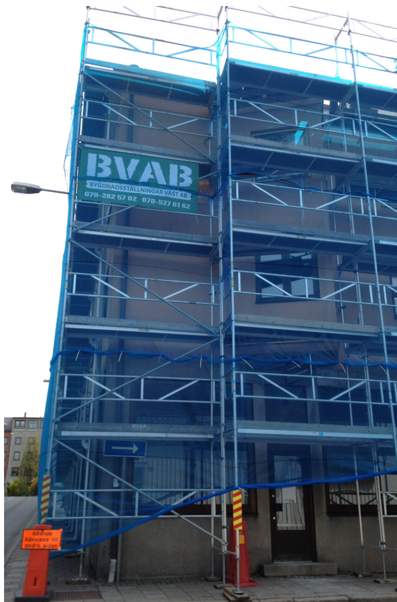
Byggnadsställning på Kålgårdsbergsgatan.
