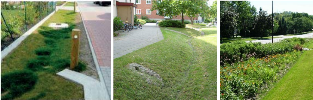
Figur 10. Exempelbilder på utformning av gräsdiken med varierad mängd växtlighet.
