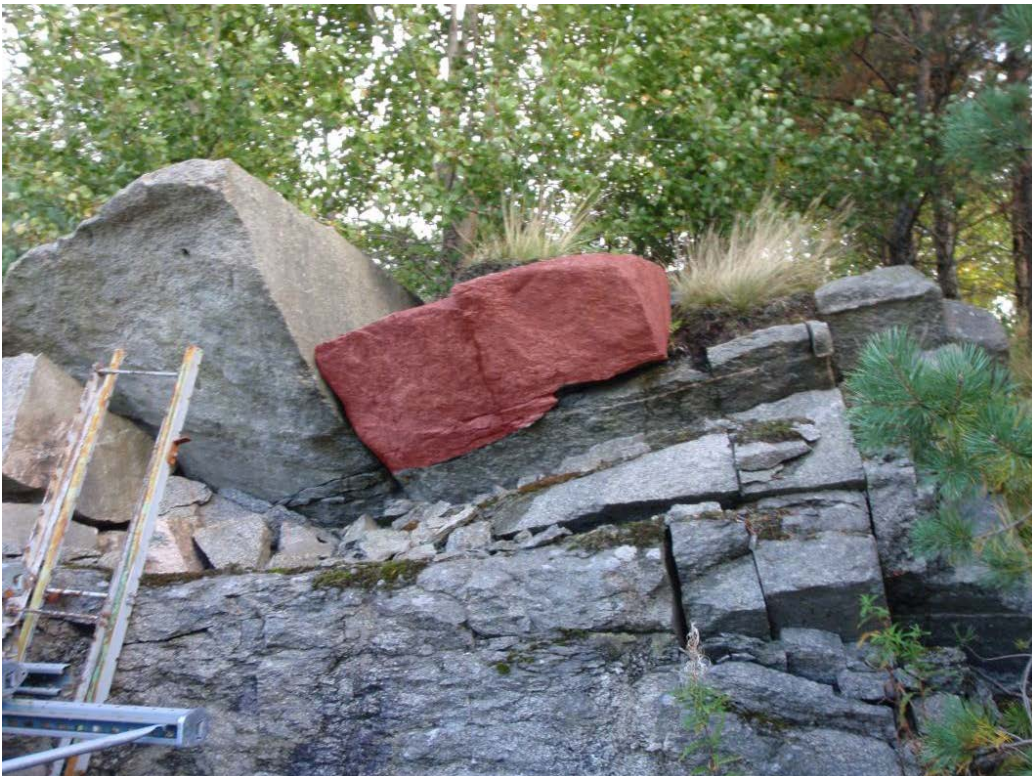
Sydöstra slutet av skärning F. Block som bedöms vara rasbenägna har markerats i rött. Vy åt ONO.
