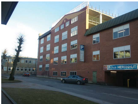
P-huset med de tre byggnadsskeppen mot Kilbäcksgatan.
