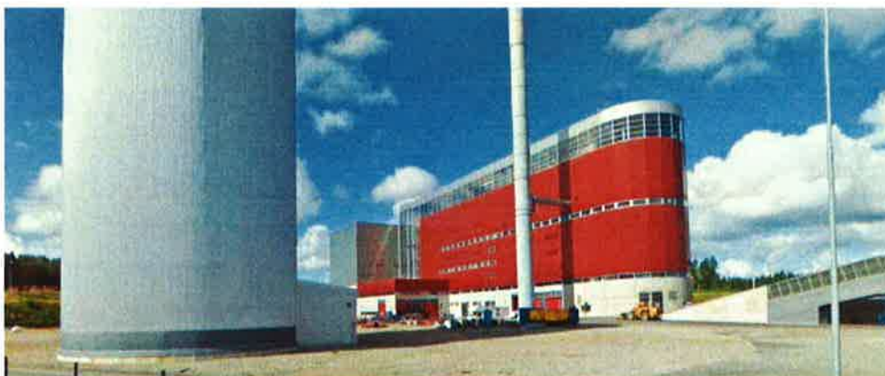
Lillesjö kraftvärmeverk togs i drift 2008, efter ca 2 års byggtid till en kostnad av 900 miljoner.
