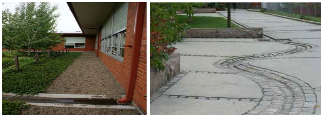
Exempel på stuprörutkastare och ränndalar i Uppsala kommun.
