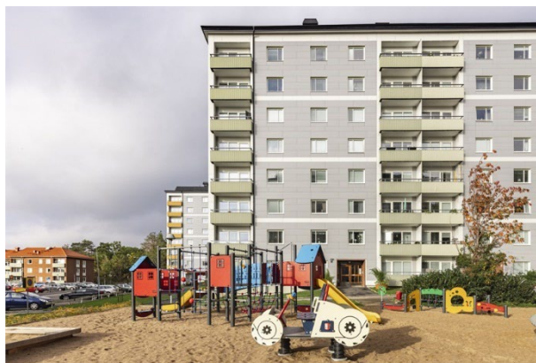
Figur 18. Renoverat skivhus på Östanvindsvägen med nytt fasadmateriäl, men bibehållen karaktär Källa: Uddevallahem
