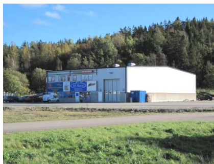
Befintlig hallbyggnad inom planområdet.
