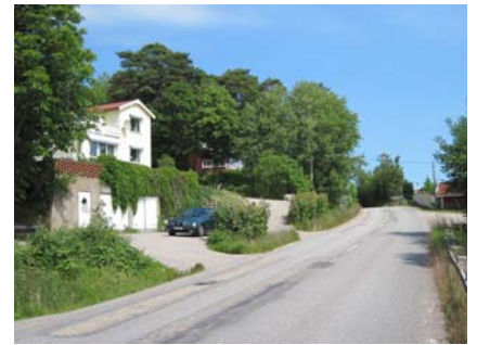
Laneberg 1:21 till vänster med boningshus, garage och infart till fastigheten. Arrendebostaden skymtar bakom träden.
