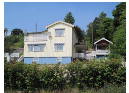
Boningshus och komplementbyggnad på fastigheten Laneberg 1:21.
