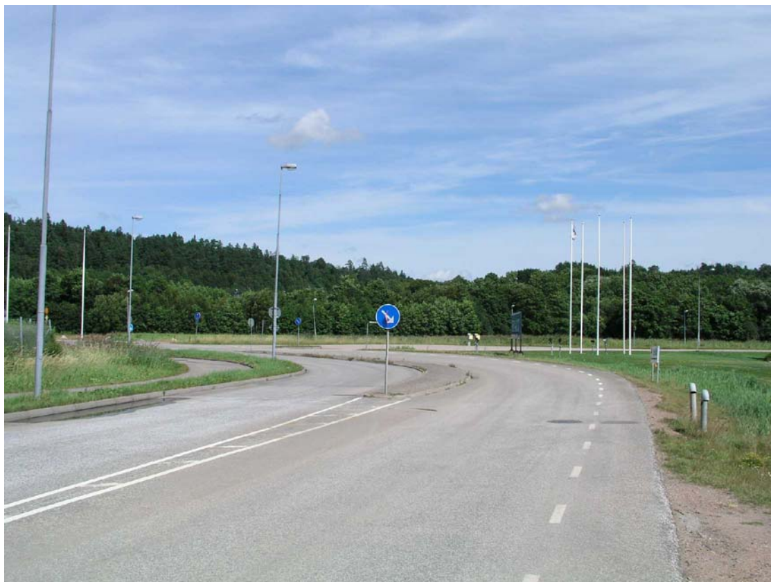
Frölandsvägen mot norr med Kärraåns skogsridå i fonden
