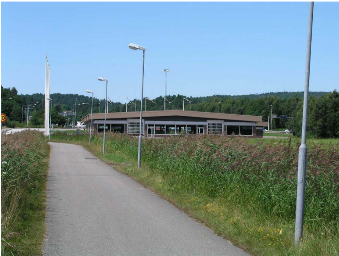
Byggnad på Spångegärdet 1 sedd från öster
