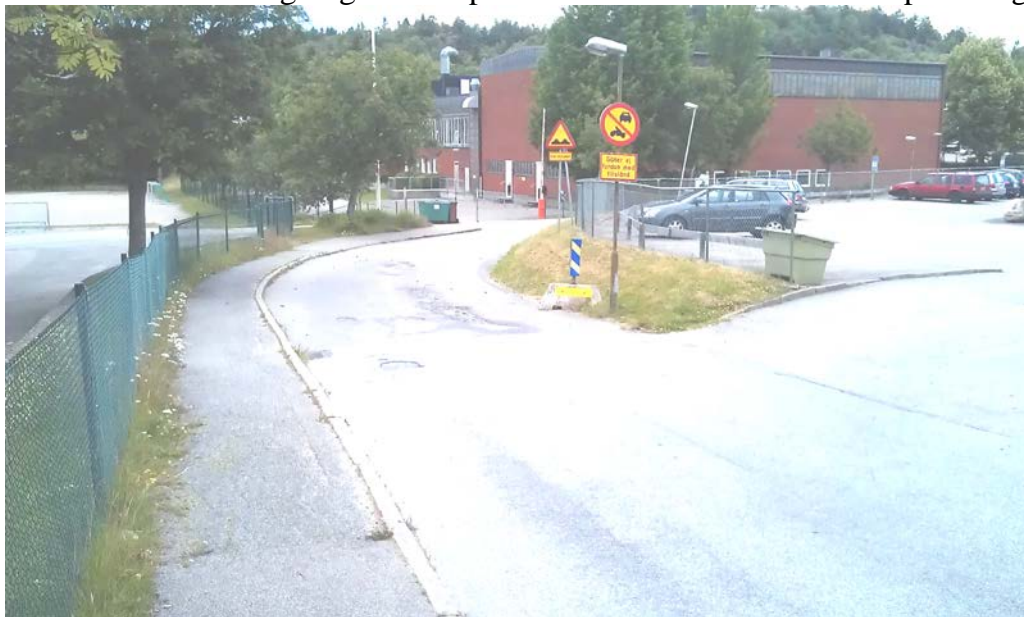
Gräsholmsvägens angöring till Äsperödsskolan, plats för angöring och trafikseparering. I detta avsnitt breddas gångbanan med ca 1 m i detaljplanen.
