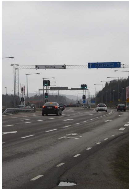
Korsningen på väg 786. Infart till södra torp och till det planerade hotellet.
