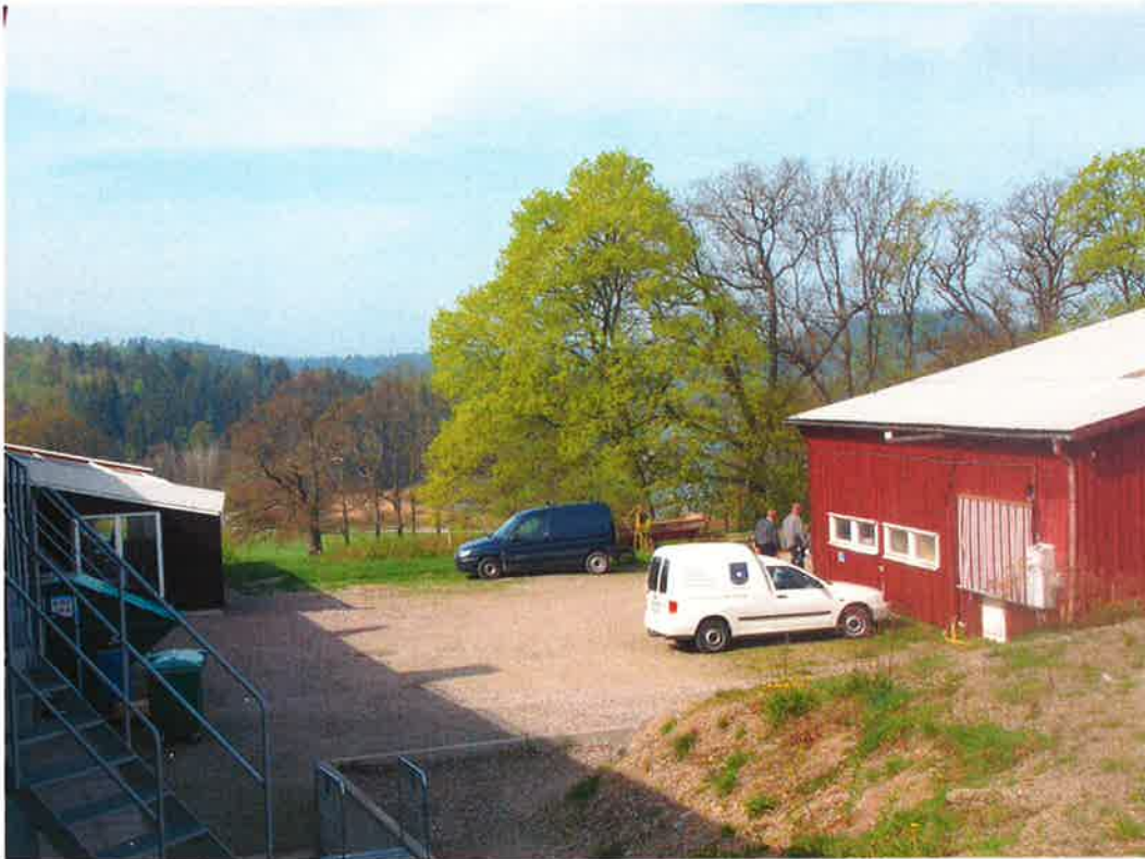
Förrådsbyggnad som rivs
