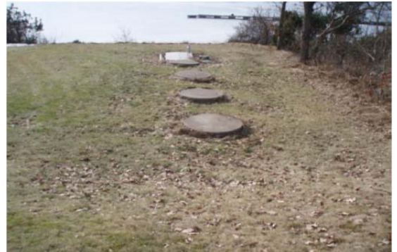
Den befintliga reningsanläggningen. Foto BBK Teknik och Miljökonsulter
