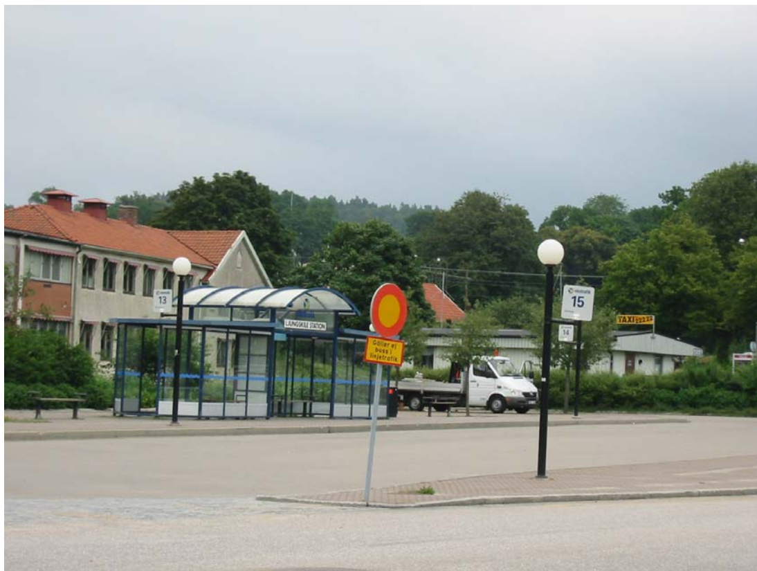
Bussterminalen sedd från väster.
