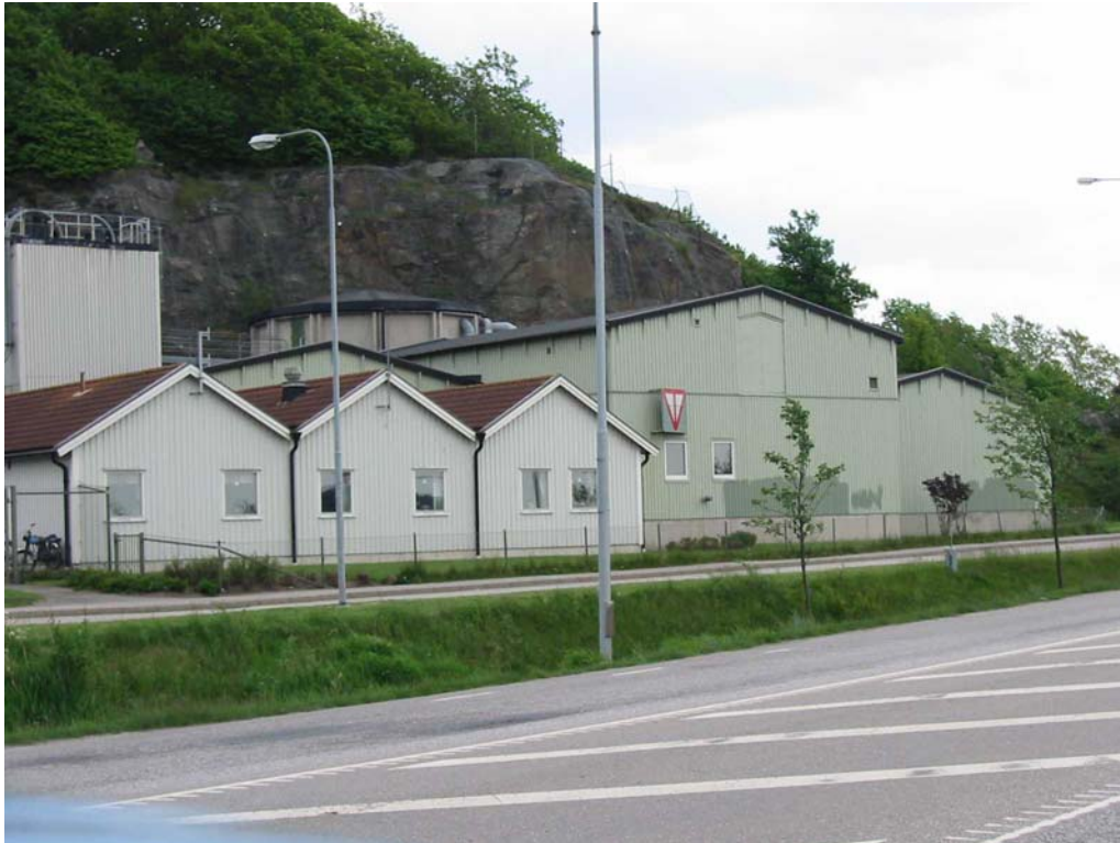
Avloppsreningsverket sett från nordväst.
