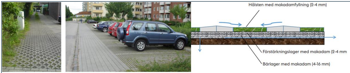
Figur 19. Till vänster: Exempel på gräsarmerade betongbeläggningar som genomsläpplig parkeringsyta. Till höger: Principskiss för genomsläpplig beläggning. Bildkälla: Stockholm Vatten och Avfall.
