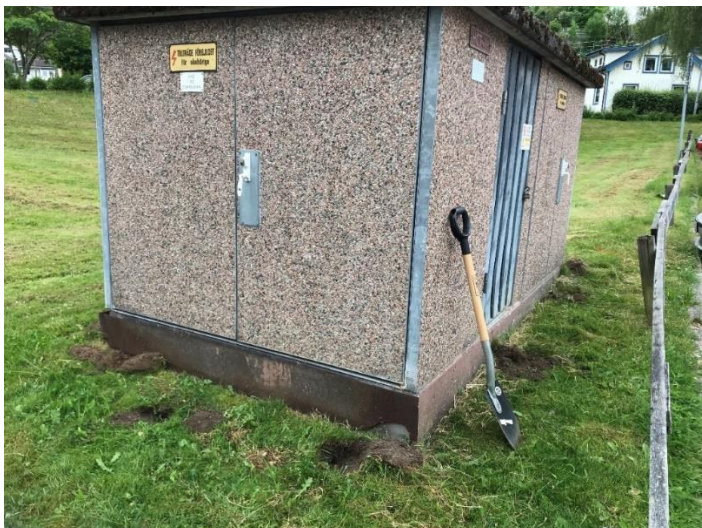
Figur 4. Runt transformatorstationen grävdes 10 små gropar till ett djup av ca 0,1 m under grässvålen.
