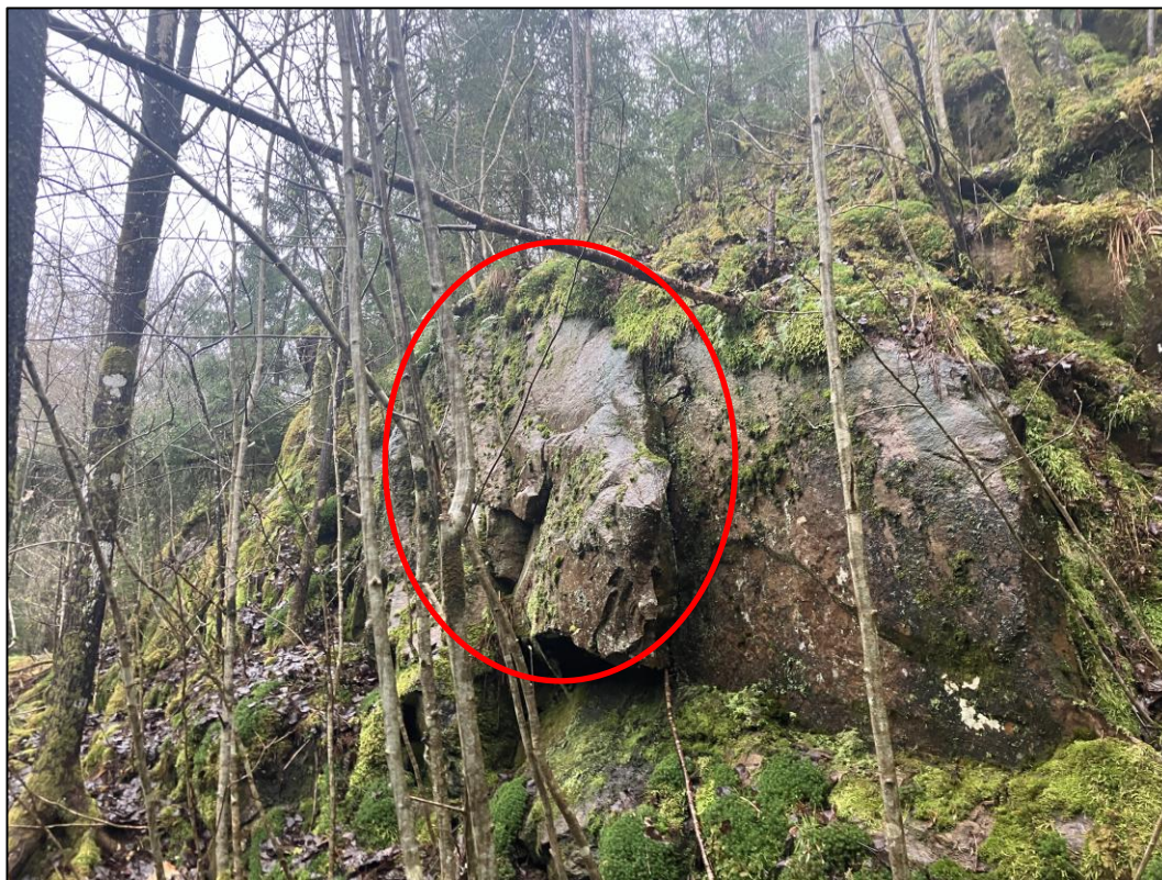
Figur 5. Berget i det sydvästra delområdet är ställvis uppsprucket även där berget är mer rundat. Block inringat i rött visar exempel på potentiellt instabilt block där rot- och frostsprängning riskerar att skapa utfall över tid.
