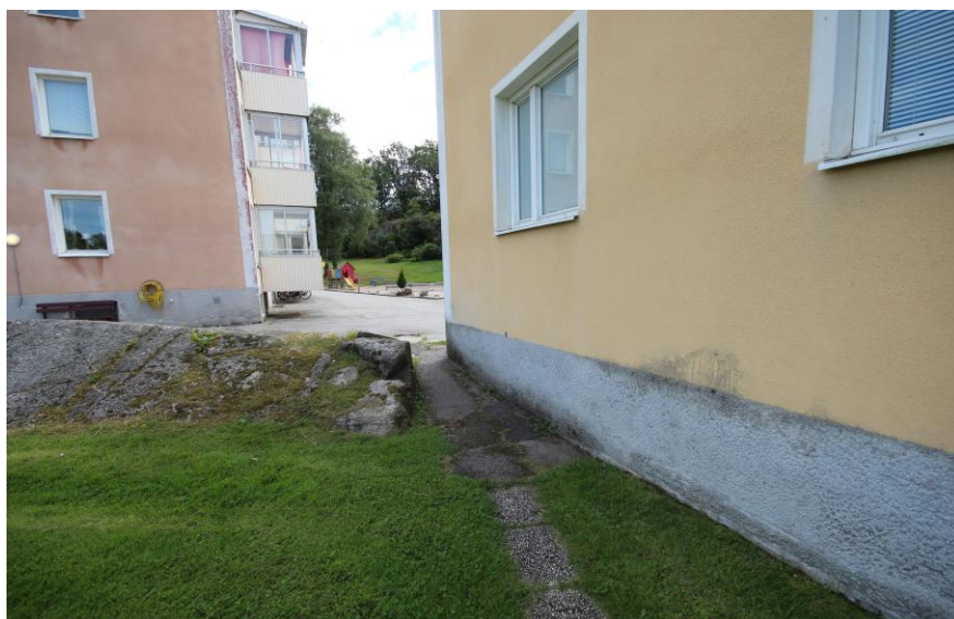
De ursprungliga fasaderna är tilläggsisolerade vilket medför att fönstren är djupt liggande i relation till fasadlivet.
