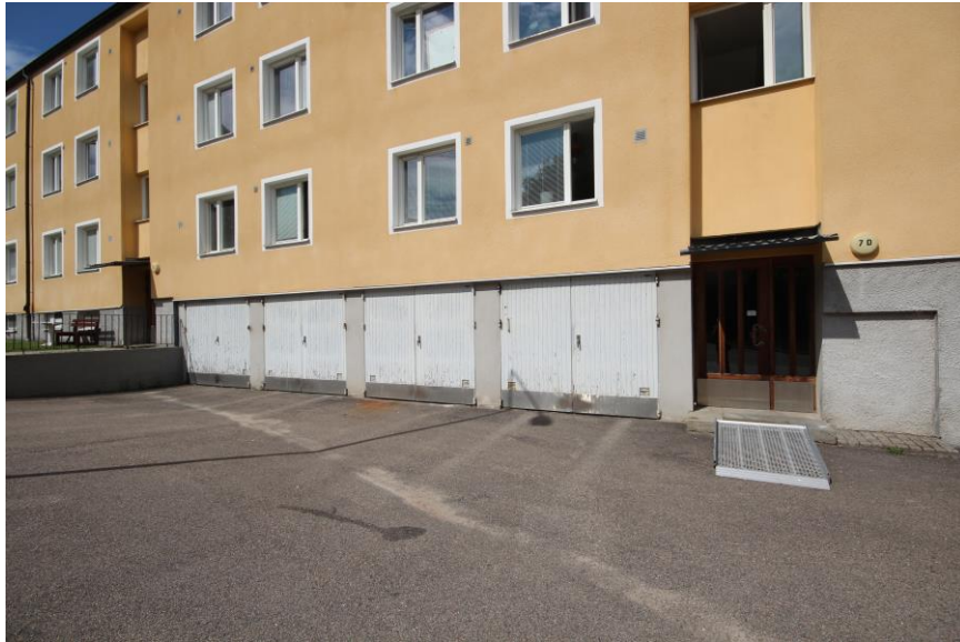
Fastigheten Resö med garageportar i original.
