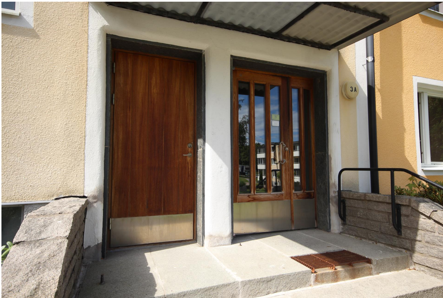
Den västliga huslängan inom fastigheten Sannäs har också originaldörrar till källaren liksom bevarade omfattningar i Fjäråsgnejs. Omfattningen med slätputs utgör ett senare tillägg.
