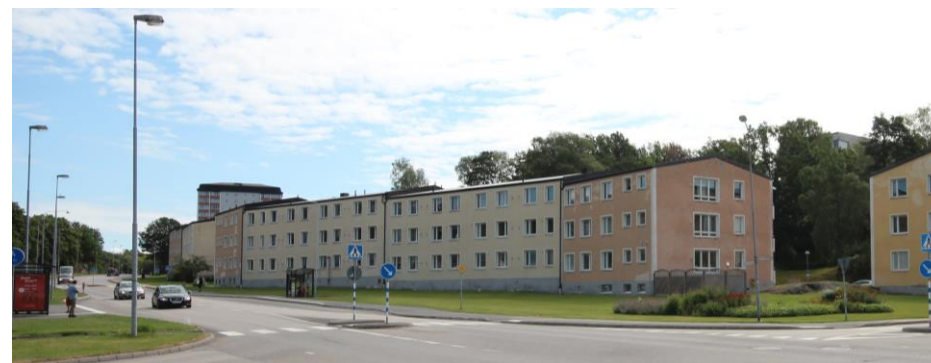
Fasaderna utmed Västanvindsvägen har en mer sluten karaktär.
