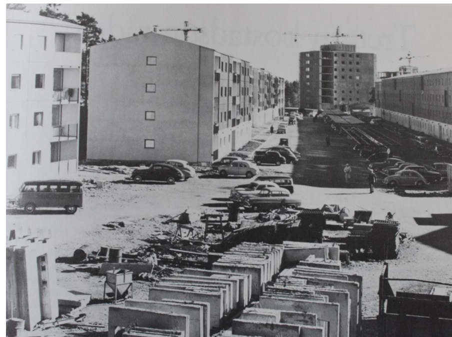
Ett av de första bostadsområden som uppfördes med förtillverkade byggelement var ett bostadsområde i Östberga i Stockholm. Förtillverkade väggar, bjälklag och trapplöp monterades på plats med hjälp av spårbundna kranar. Husen uppfördes i mitten av 1950-talet. (Ur Folkhemmets bostäder 1940–1960)
