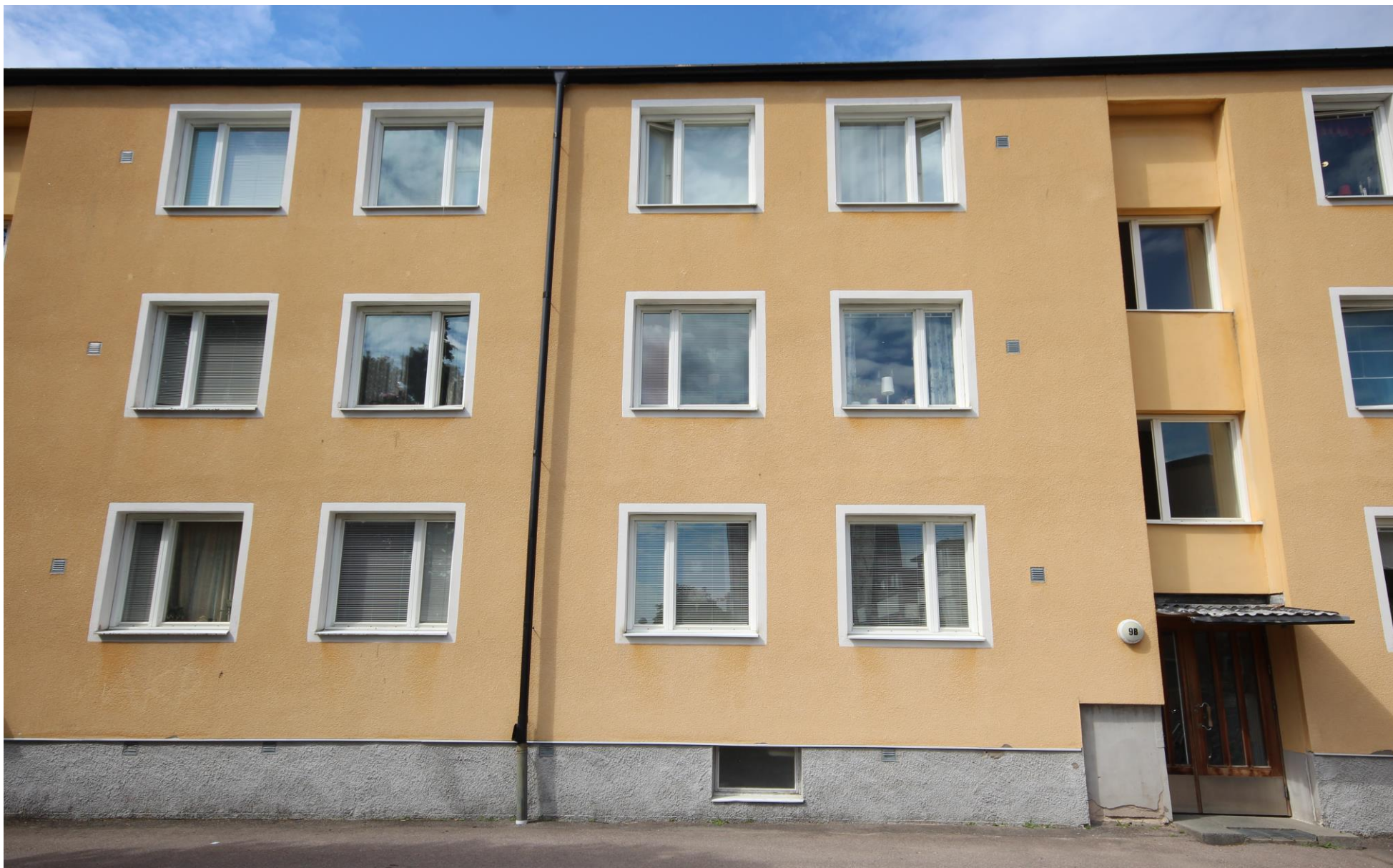
Fönstren är möjliga i original men med en sekundär plåtbeklädd alternativt utbytta med ursprunglig luftindelning bibehållen.
