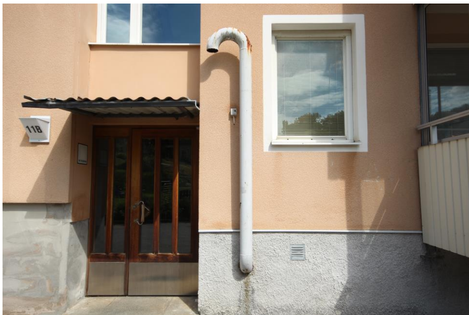
Senare tillkomna installationer i fasad.
