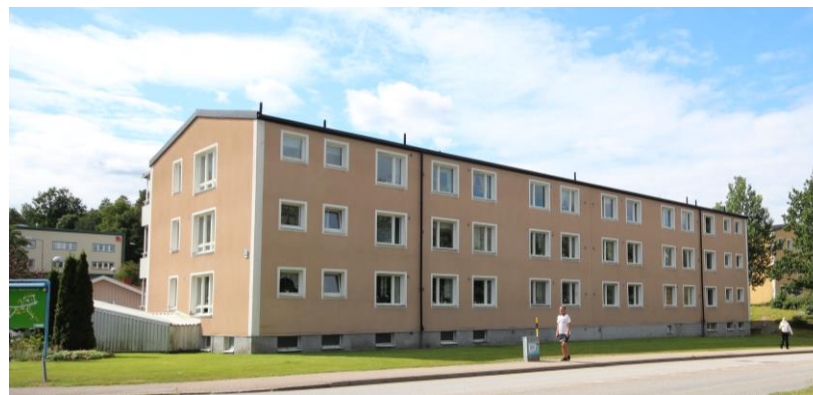
Bostadshusen utgörs av lamellhus övervägande i tre våningar.
