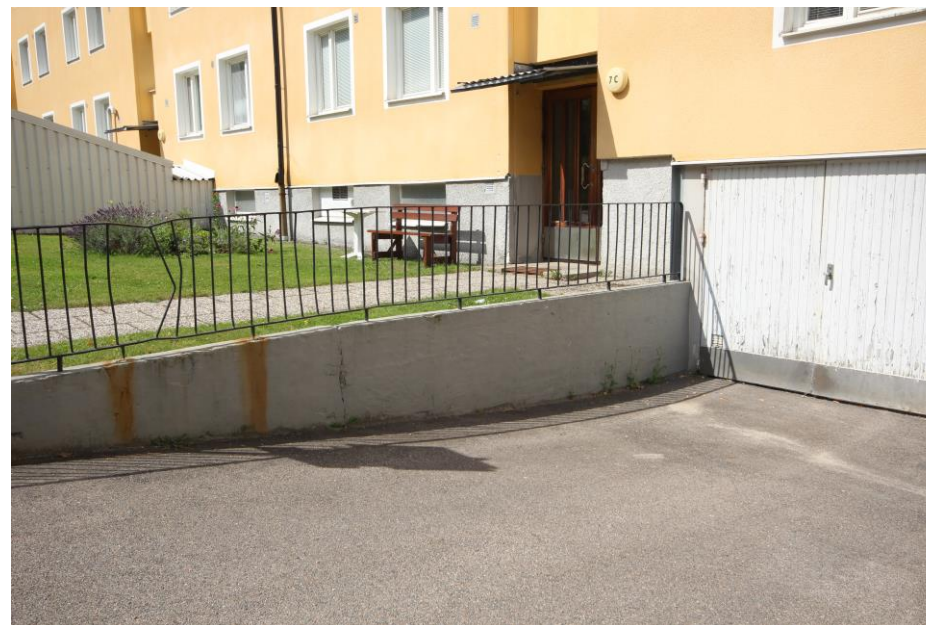
Exempel på ursprunglig stödmur i gjuten betong samt räcke i original.
