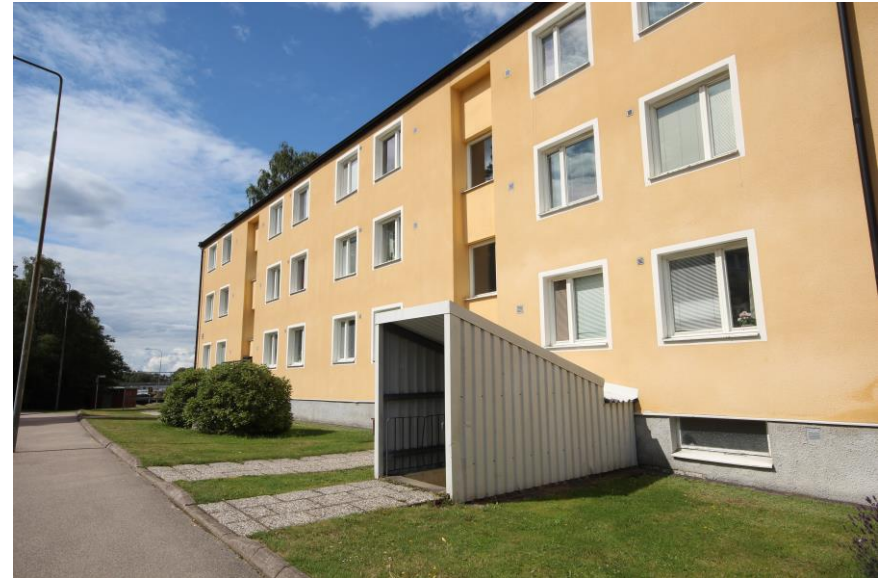
Flertalet källartrappor har en sekundär överbyggnad av plåt.
