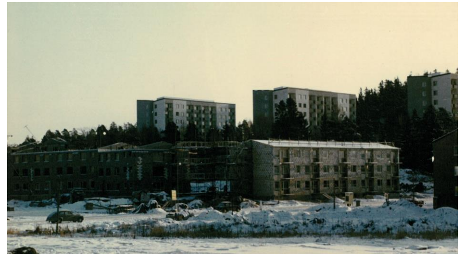
Området under uppförande. Ytterväggarnas lättbetongblock är alltjämt synliga. (Uddevallahem)
