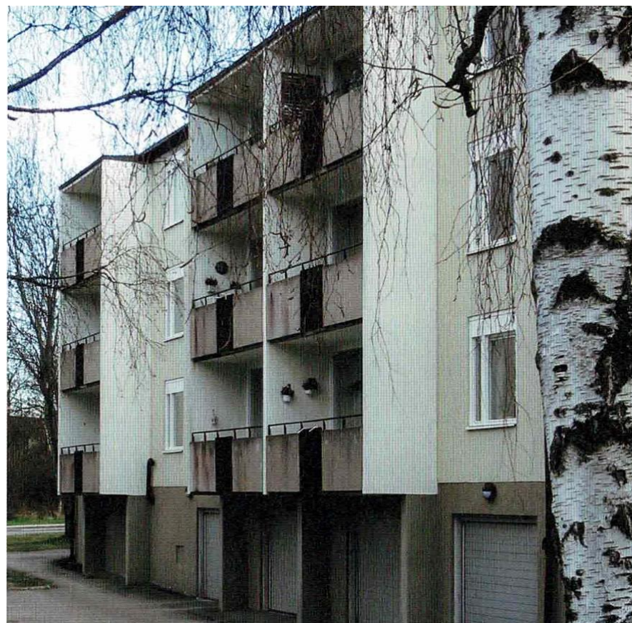
Balkonger med förtillverkade stödsivor av betong.
