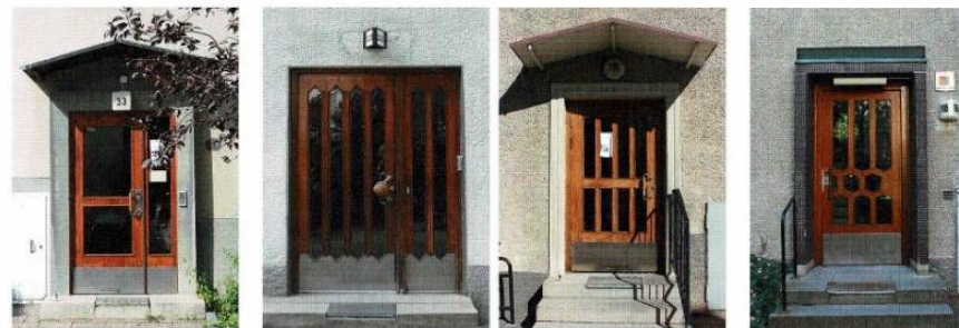
Entrépartierna var ofta omsorgsfullt utformade med material och detaljer av hög kvalitet.
