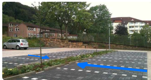
Exempel på växtbädd av typ regngård, samt mindre växtbädd vid parkeringsplats där pilarna illustrerar vattnets väg.
