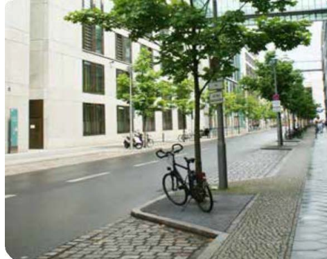
Exempel på vattengenomsläpplig beläggning och skelettjordsplanterade träd i Uppsala kommun.
