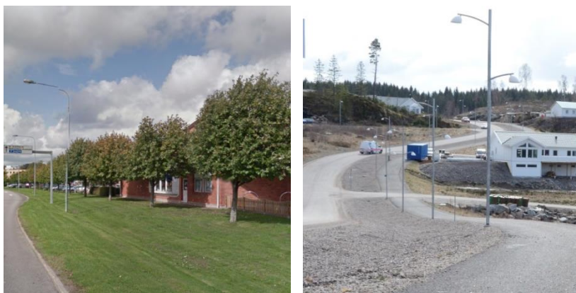
Svackdike längs med Bastiongatan och makadamfyllda diken längs Västra Sundskogsvägen
