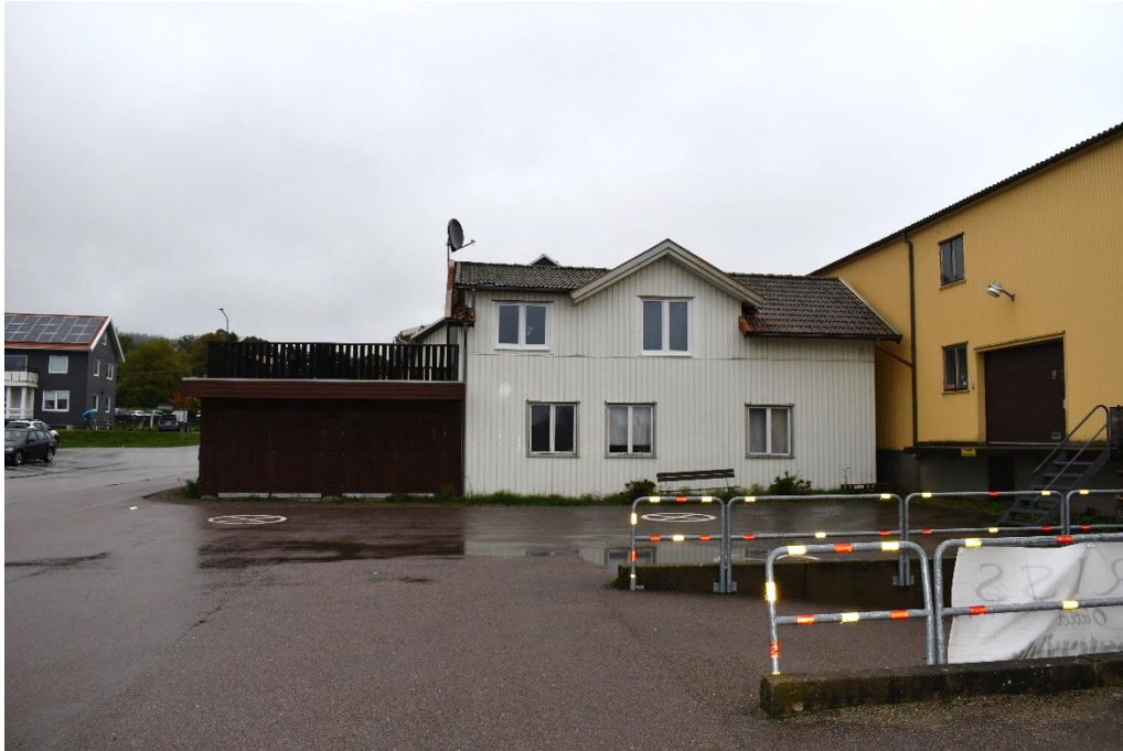
Västra fasaden på det mindre (gårdshuset) huset. Denna sida har en frontespis, tillbyggd med en lätta. På andra våningen sitter nyare aluminiumklädda fönster.
