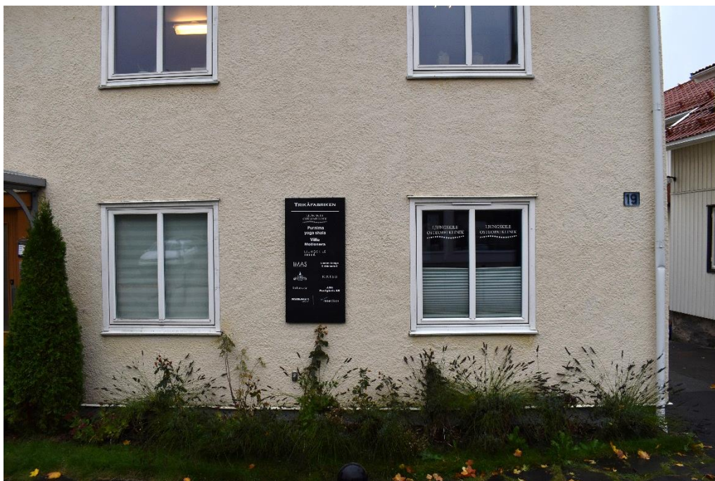
Nya pivothängda aluminiumfönster i fabriken's äldsta huskropp.
