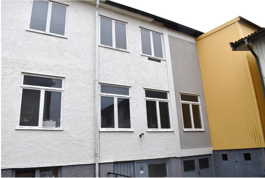
Den norra fasaden på den putsade fabriksbyggnaden vänder sig mot en innergård som bildas mellan tillbyggnaderna, annexet och gårdshuset. Här finns ännu originalfönster kvar. T-postfönster på nedervåningen som sitter i stickmaskinrummet samt tvåluftsfönster på övervåningen.
