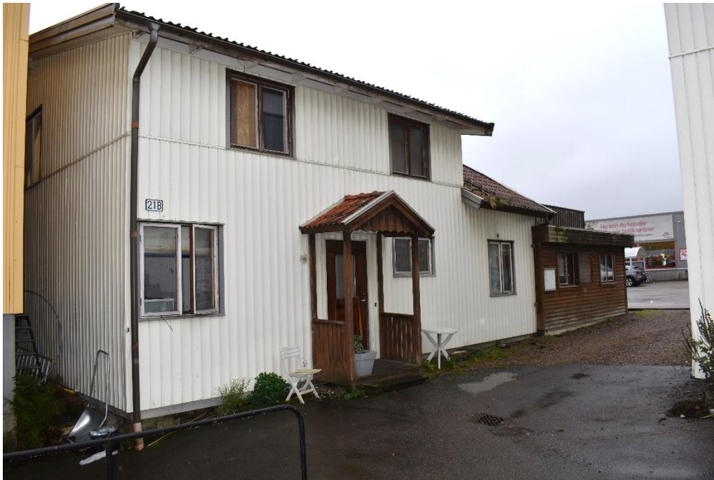
Det andra huset, det som har kallats gårdshuset, ligger i vinkel, tätt intill den plåtinklädda lastkajen, är även det klätt med vit fasadplåt och har tvåkupiga lertegelpannor på taket. Huset är förlängt med ett dubbelgarage mot norr och har ett brett taklyft närmast fabriksbyggnaden.
