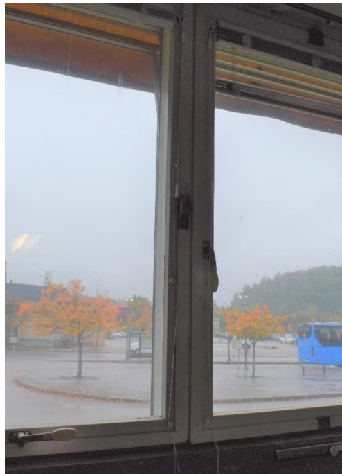
På södra fasaden har fönstren bytts ut till aluminiumfönster i de äldsta delarna. Medan originalfönstren ännu sitter kvar i tillbyggnaden från 1960-talet.
