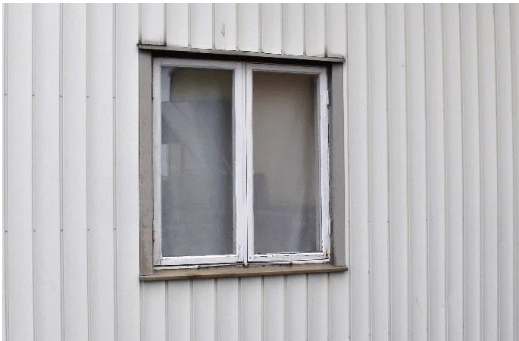
Ett äldre 1950-talsfönster i trä på gårdshusets västra fasad.
