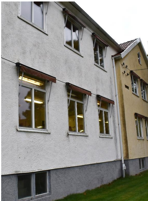
På södra fasaden har fönstren bytts ut till aluminiumfönster i de äldsta delarna. Medan originalfönstren ännu sitter kvar i tillbyggnaden från 1960-talet.
