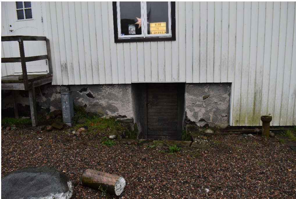
Mitt på norra fasaden, vid källarnedgången, ser man en bit av en äldre naturstensgrund som spritputsats. Källardörren är en äldre och låg dörr med spontad liggande panel.
