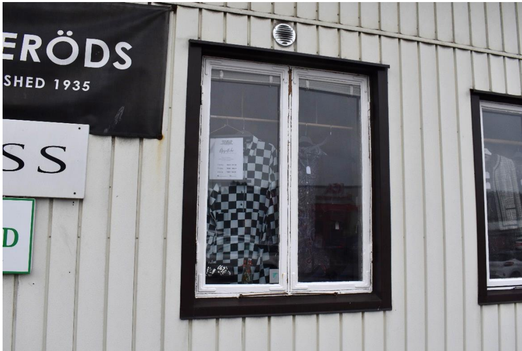
Fönstren är nästan enbart sidohängda och ospröjsade men äldre pressat hörnbeslag finns på flera av fönstren. Den typen av hörnbeslag var vanlig hela första hälften av 1900-talet.
