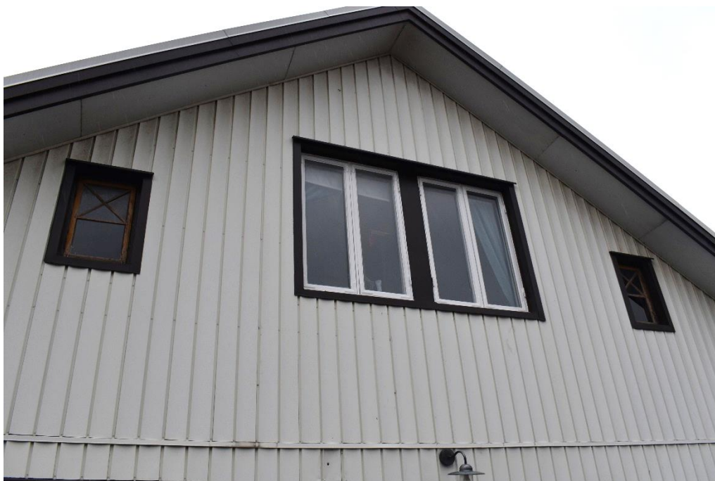
På gaveln mot Vällebergsvägen sitter två gavelsidofönster med krysspröjs. Dessa samt ytterligare ett spröjsat fönster på södra fasaden är kvar från husets äldre utformning.
