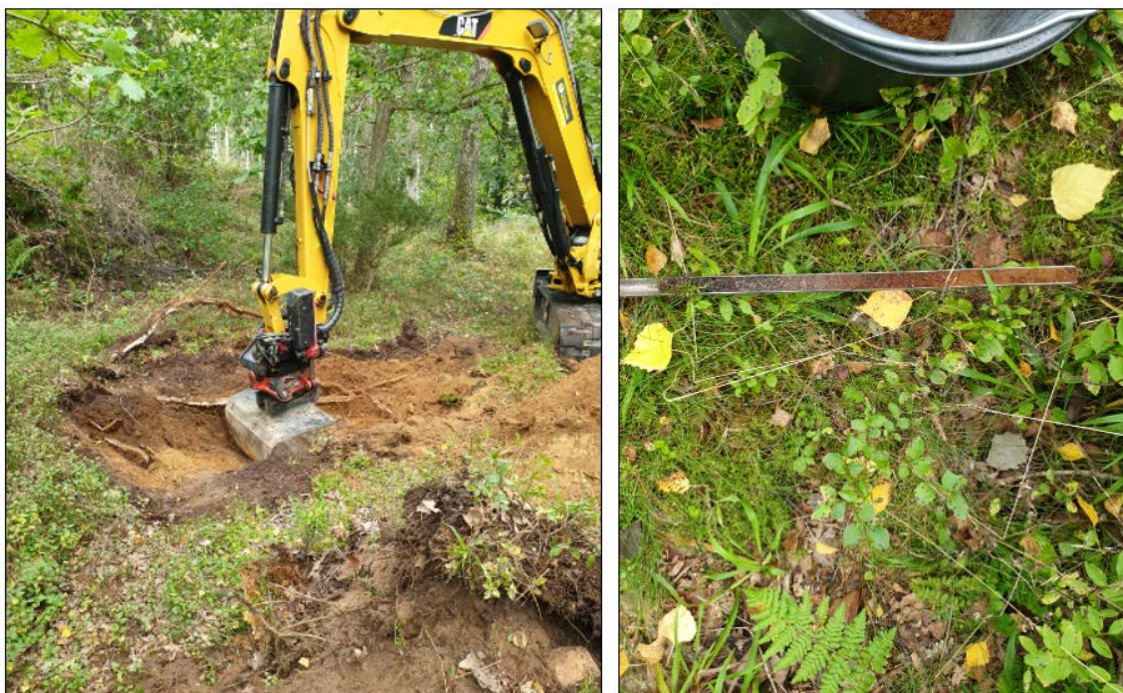
Figur 4. Provgropsgrävning med maskin (PG20-05) till vänster, uttaget prov med MUK (SP20-01) till höger.
