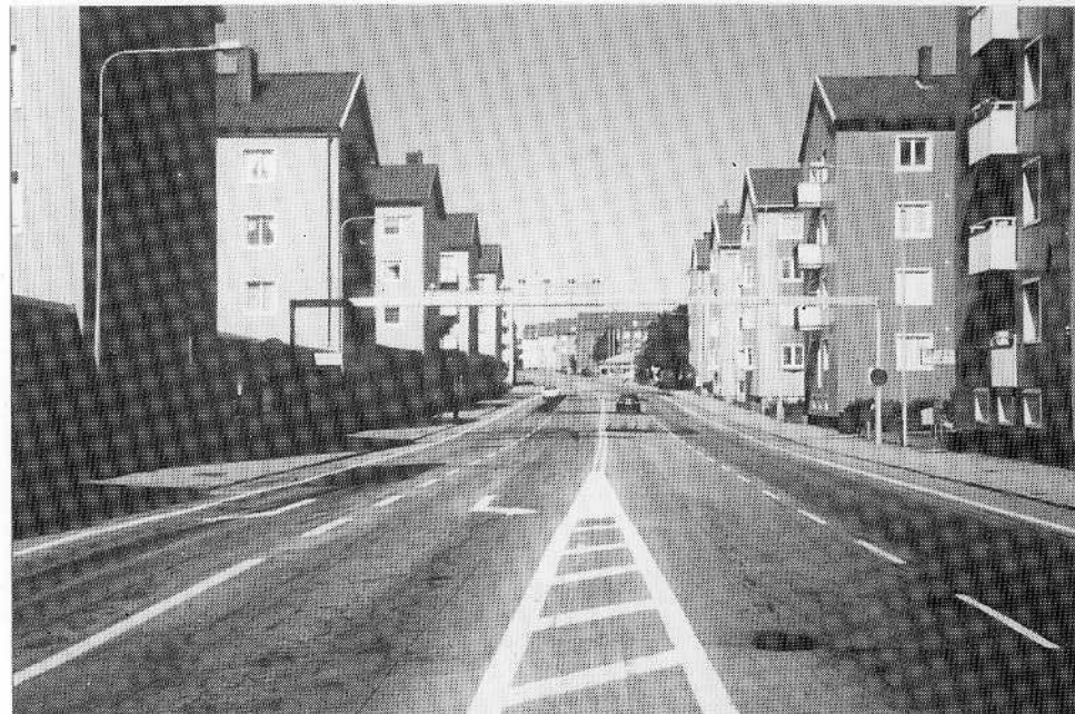
Strömstadsvägen mot väster före ombyggnad
